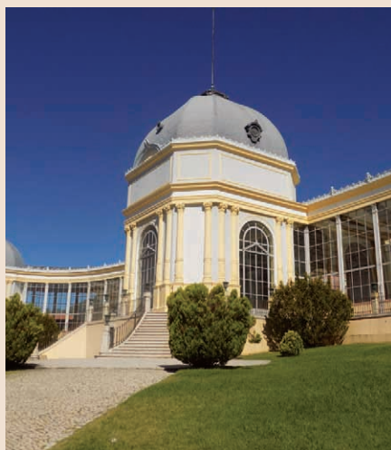
Pavilhão de Exposições
